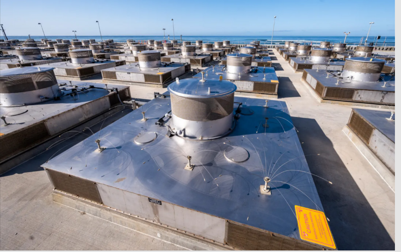
Kaliforniya, San Clemente yakınlarındaki kapatılmış San Onofre nükleer santralinde depolanan kullanılmış nükleer yakıt. Paul Bersebach / MediaNews Group / Orange County Register via Getty Images
