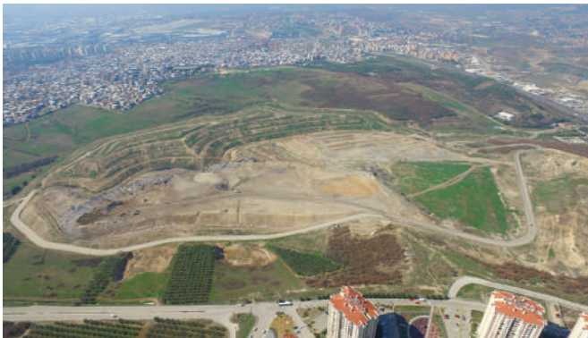
Şekil3-6: Yenikent Katı Atık Düzenli Depolama Sahası ve Enerji Üretim Tesisi
