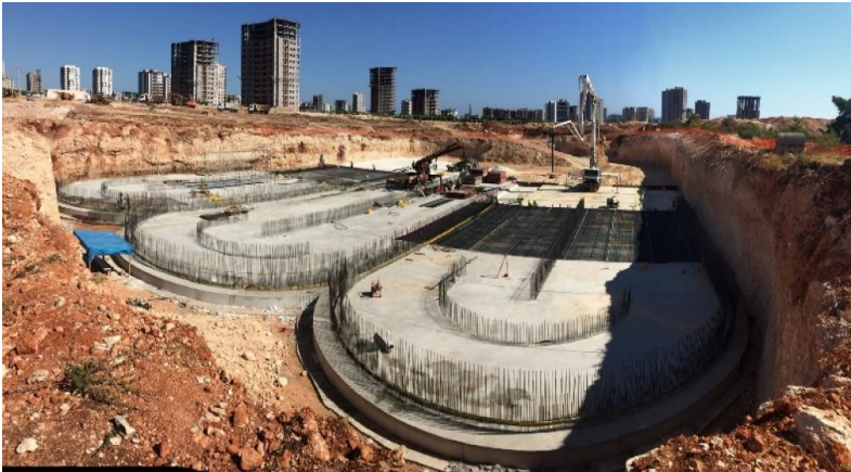
Fotoğraf 1: Mezitli Atık Su Arıtma Tesisleri İnşaatı, 2016
