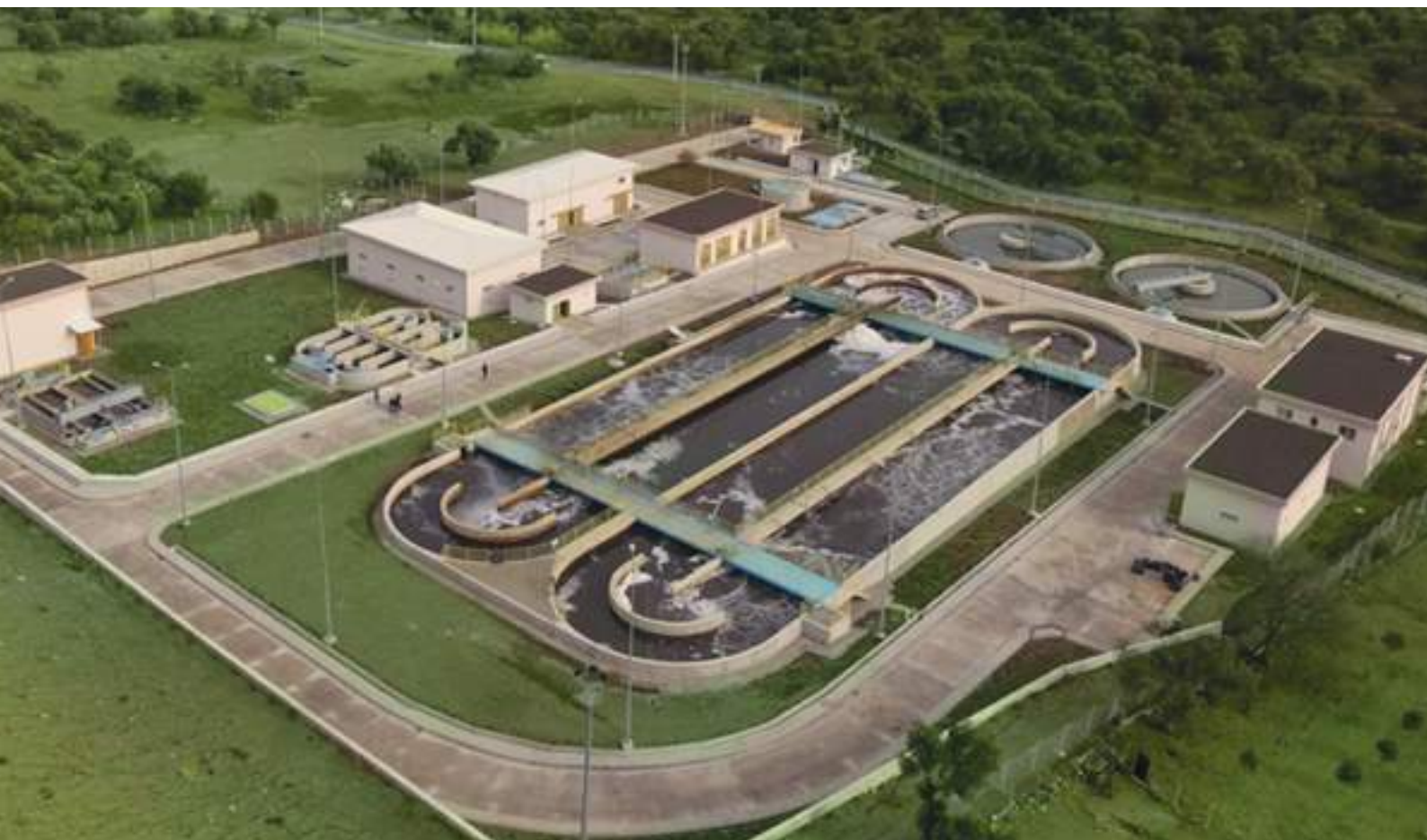
Çiğli Atık Su Arıtma Tesisi
