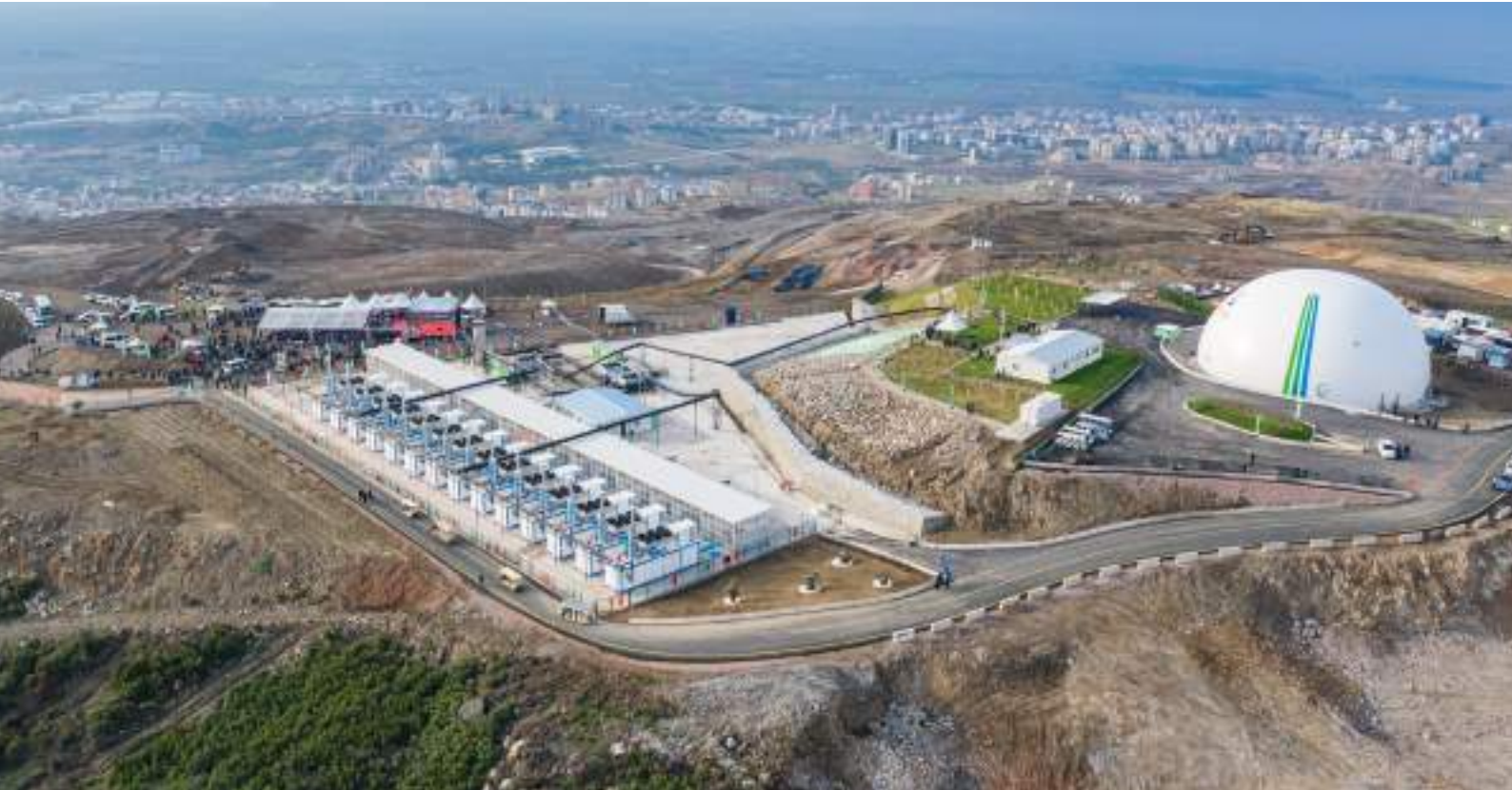
Harmadalı Düzenli Atık Depolama ve Biyogaz Tesisi
