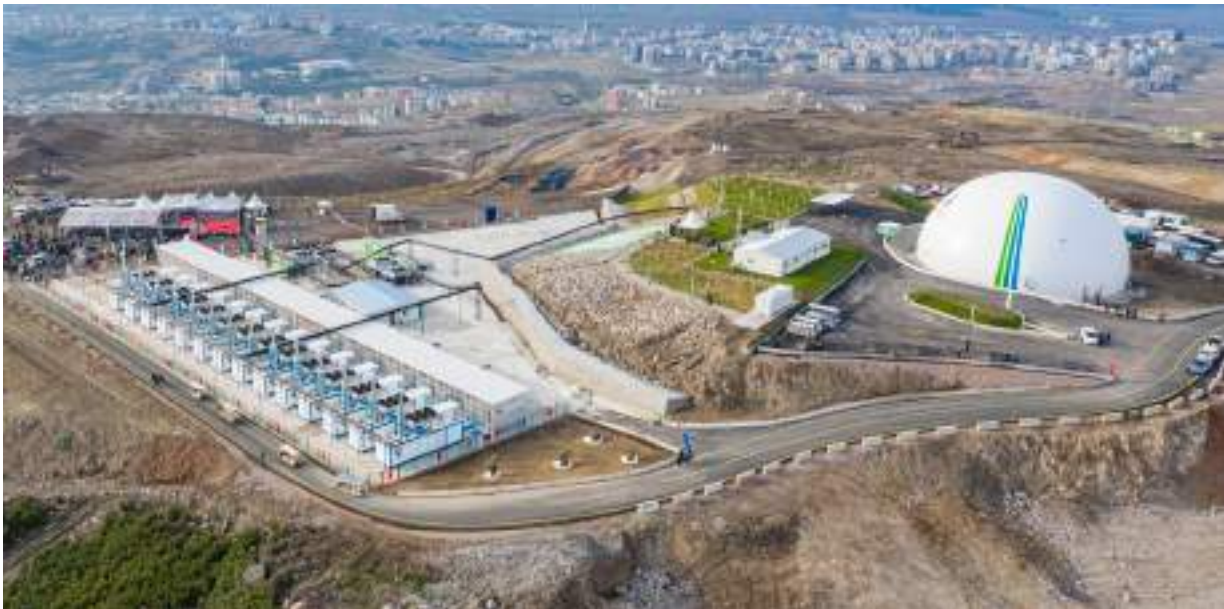
Harmandalı Düzenli Atık Depolama ve Biyogaz Tesisi
