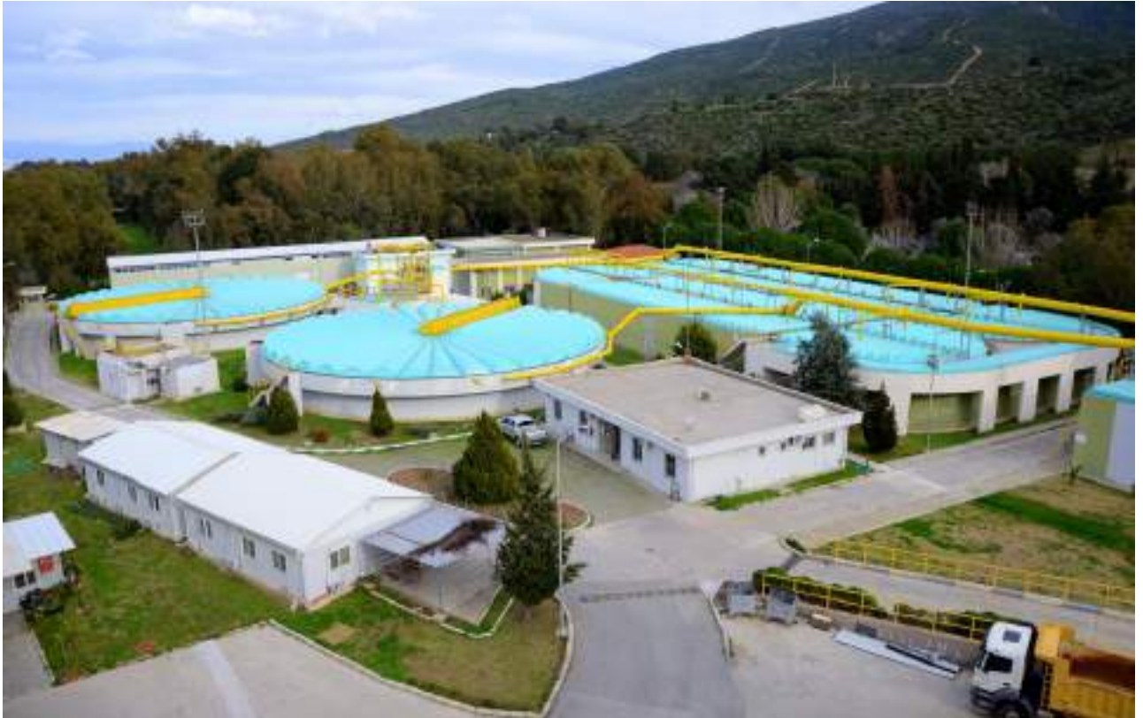
Güneybatı İleri Biyolojik Atıksu Arıtma Tesisi
