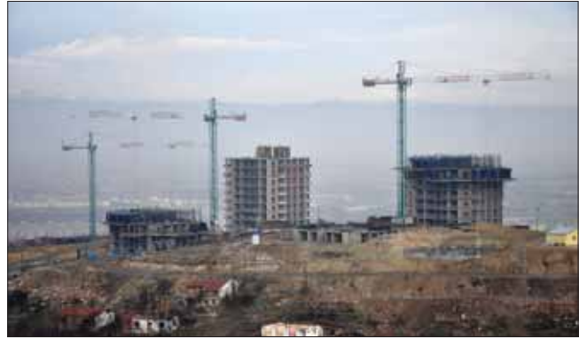
Karapınar Vadisi inşaat çalışmaları
