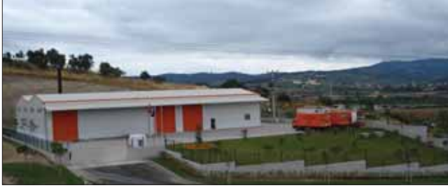
Tıbbi Atık Sterilizasyon Tesisi
