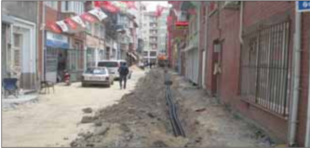
Telefon Kablolarının yeraltına alınması
