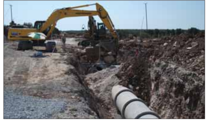
Yağmur Suyu Kazı-Dolgu İnşaatı
