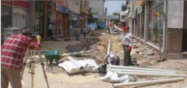
Yağmursuyu hattının döşenmesi
