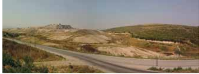
Kent Katı Atık Düzenli Depolama Alanı
