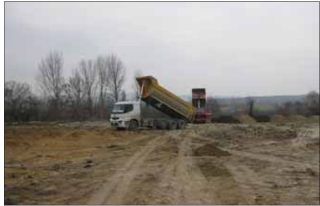
Hafriyat Döküm Sahası Sonrası
