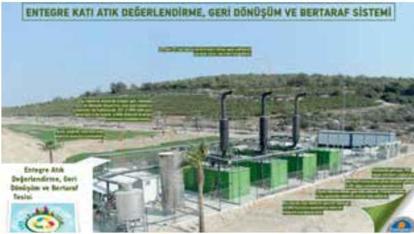
Şekil 3. İçten Yanmalı Her Biri 1,2 MWh Güce Sahip Olan Gaz Jeneratörleri
