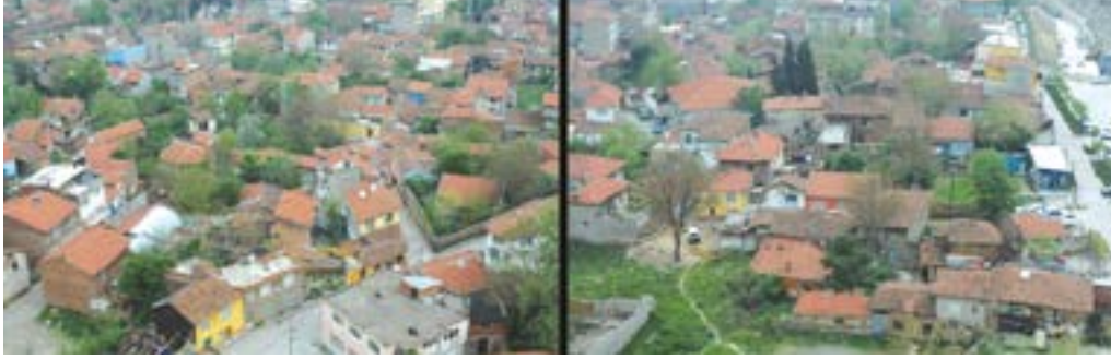
Foto 1. Yenileme Öncesinde Bölgenin Dokusu (Osmangazi Belediyesi 2008)
