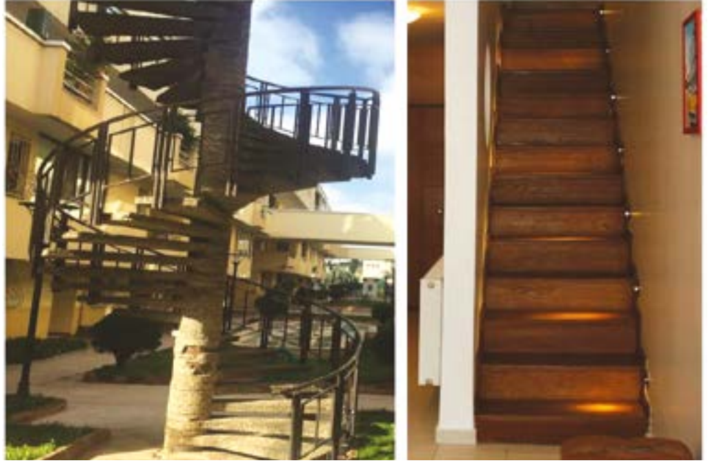
Şekil 3. Üst kottaki koridora bağlanan ana merdiven (sol), dubleks daire içi merdiven (sağ)
